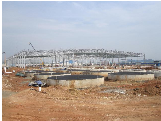
弊社潤滑油工場建設状況
