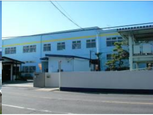
「塗装後の外壁」
