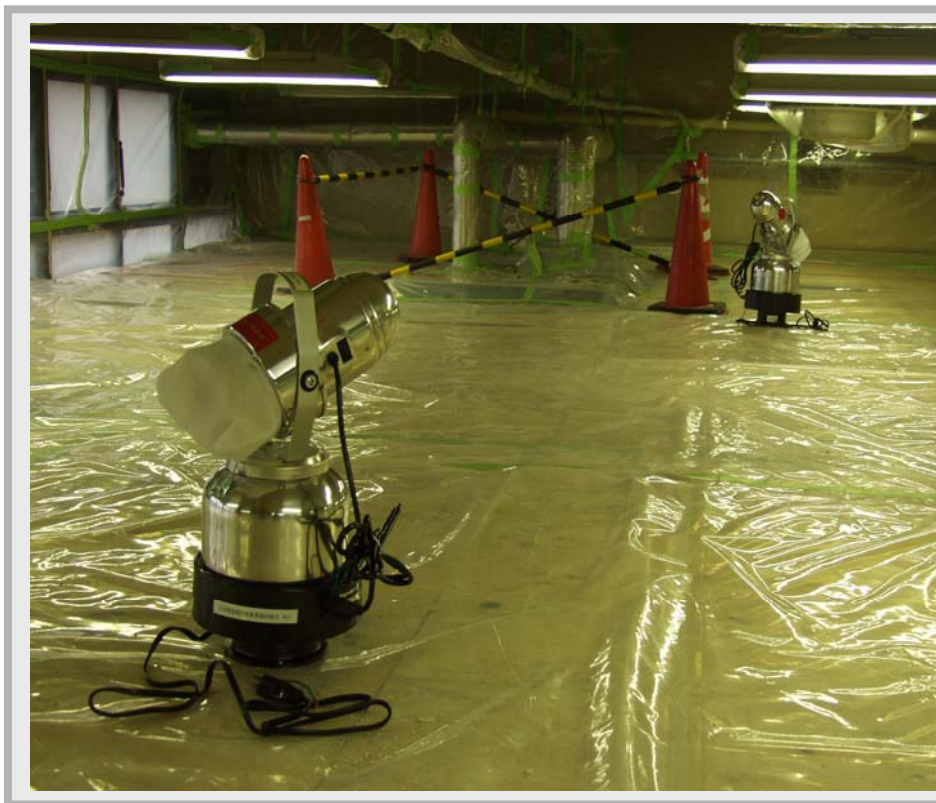
「アスベスト封じ込め工法」写真
