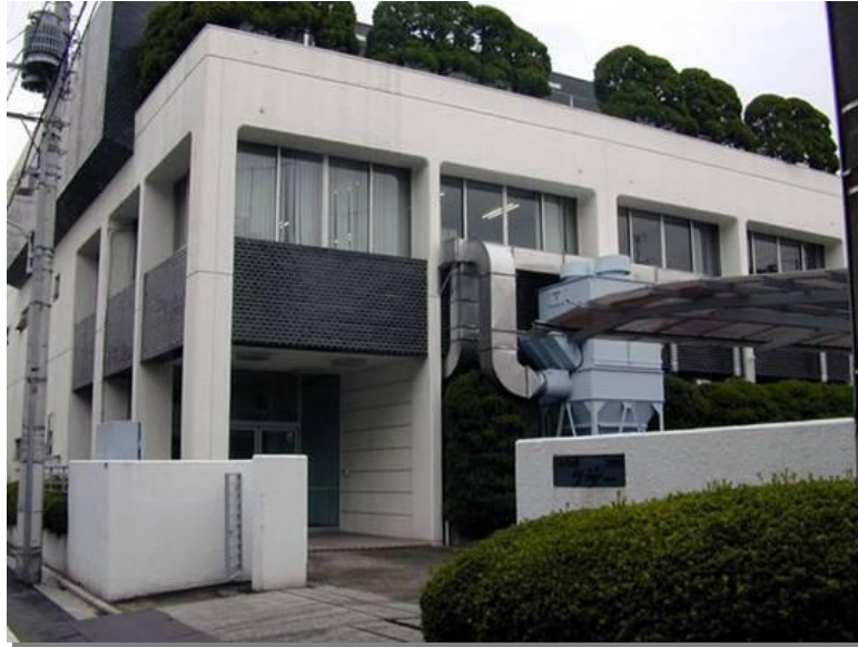
設備増強の必要性により第二工場借り入れへ
