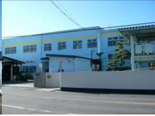
「塗装後の外壁」
