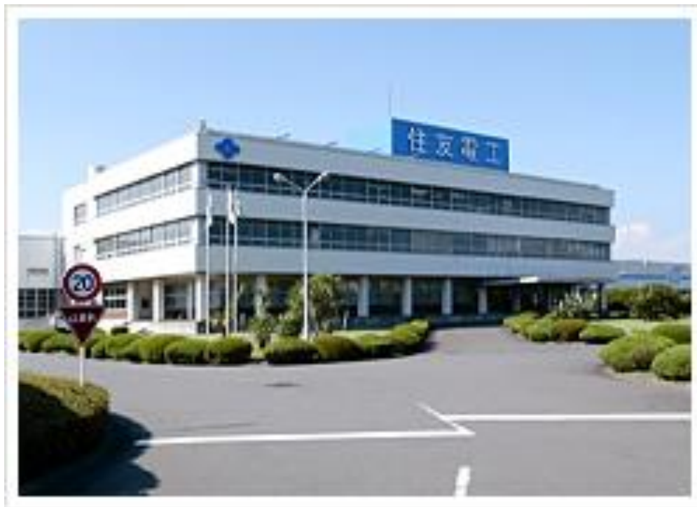
横浜製作所南事務所
