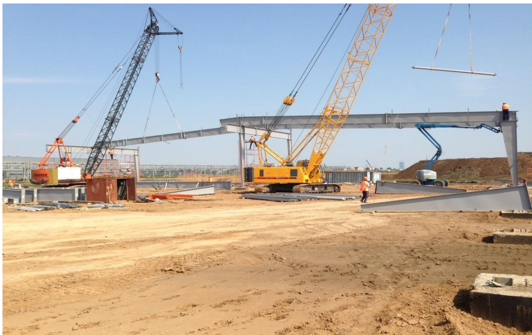
工場建築現場
