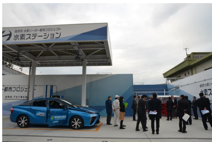
【水素ステーション：福岡市水処理センター】
